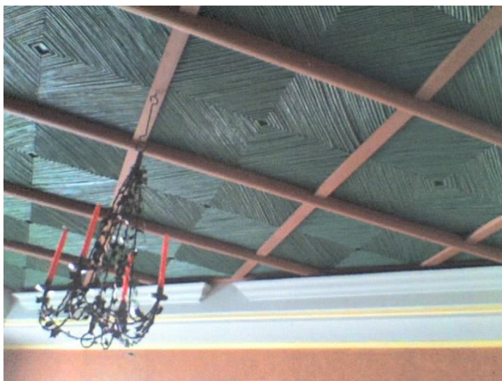
Plafond du bar
